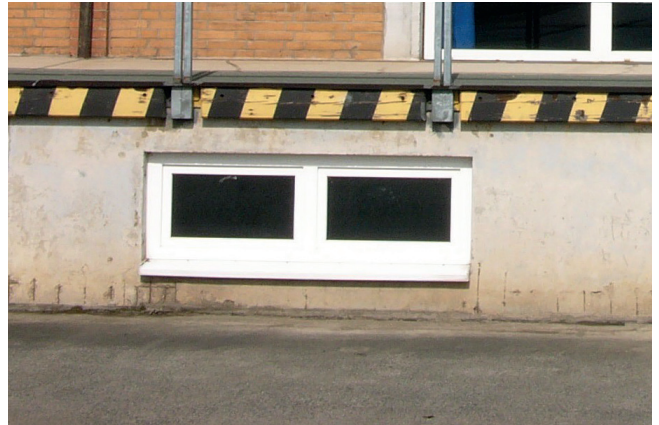
Abb. 18: Kellerfenster mit Sockel
