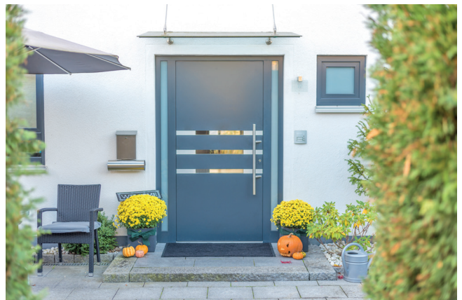
Abb. 19: Aufkantung am Gebäudezugang
