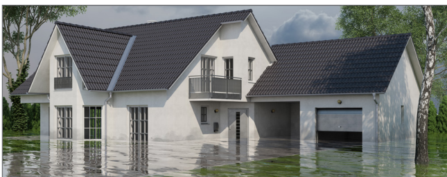
Abb. 3: Überflutung eines Gebäudes
