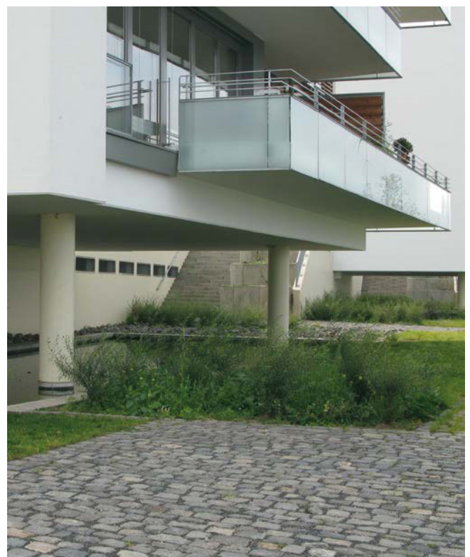
Abb. 31: Aufständigung eines Gebäudes
